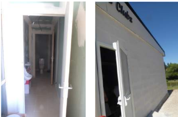
Installation du sanitaire - Salle du Mille-Clubs
